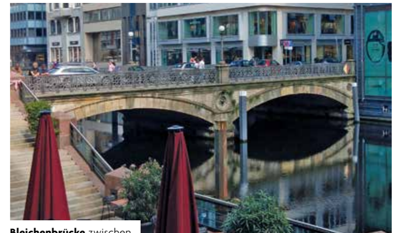
Bleichenbrücke zwischen Große Bleichen und Neuem Wall.
